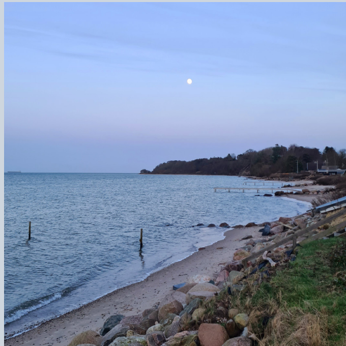
Foto: Strib - Dæmningen
